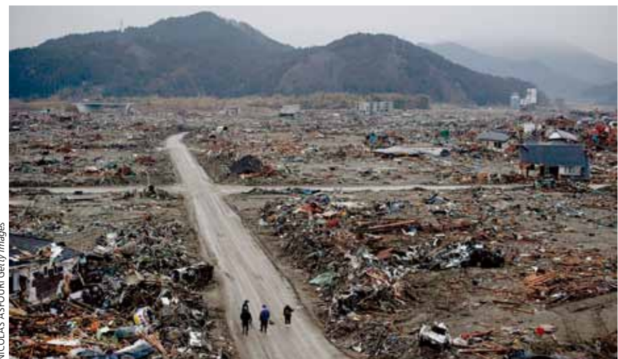
甚大な被害 東日本大震災をもたらした超巨大地震の揺れと津波で破壊された陸前高田市。
