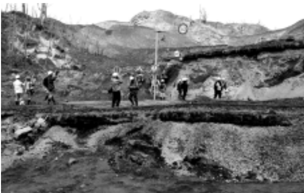
画像 S8-B：2000年潜在ドーム南側の正断層群。旧国道230号線が階段状になっている。2001.4.8撮影。
