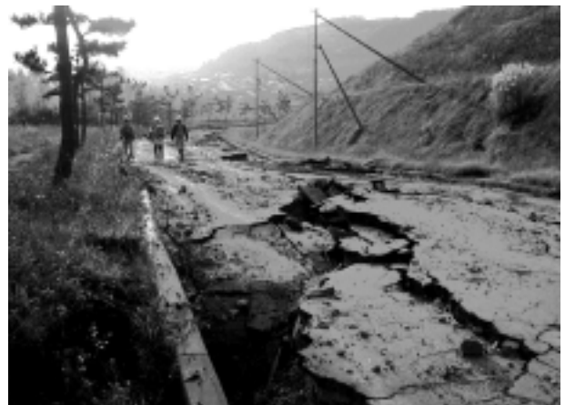
画像 S9-B：幼稚園周辺の旧町道、地殻変動によってズタズタになっている。2000.11.5撮影
