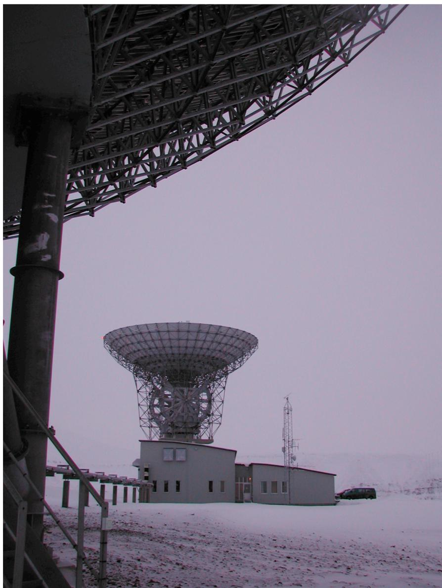
図 2.3 (奥) ESR 直径 32 m の可動式レーダー, (手前) 42 m レーダー.
